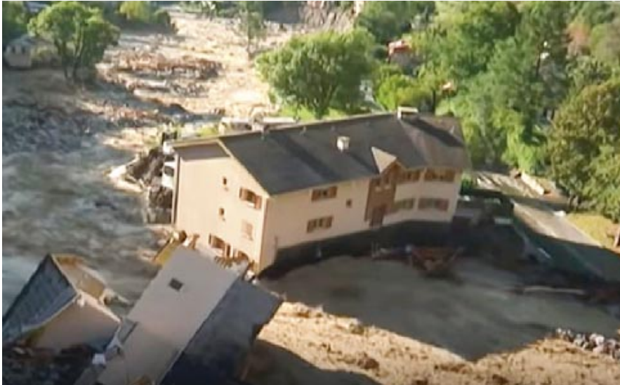
Die Wassermassen ließen dem Gendarmeriegebäude im Vordergrund keine Chance. Das Wohngebäude dahinter ist nicht bewohnbar.
