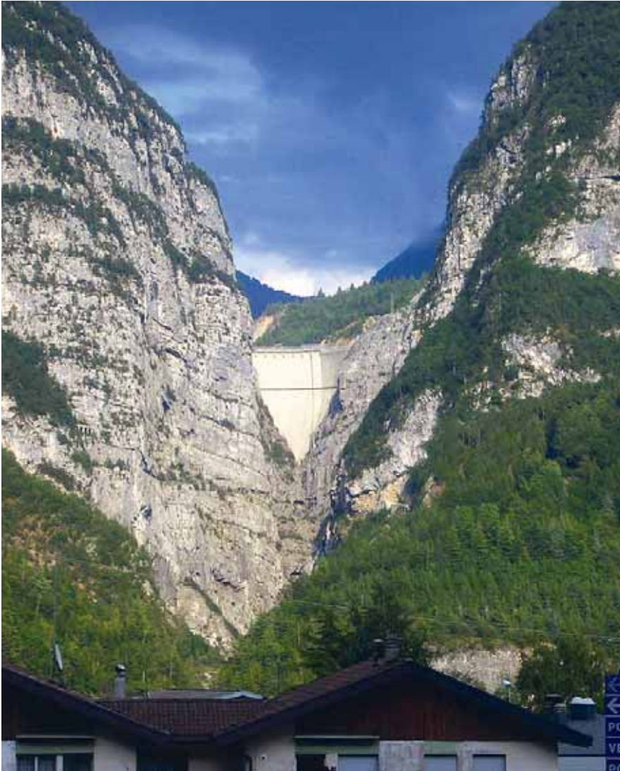
Die gigantische Staumauer mit 261 Metern Höhe hat dem Druck der 25 Millionen Kubikmeter standgehalten und ist heute ein Mahnmal für die Geschichte.
